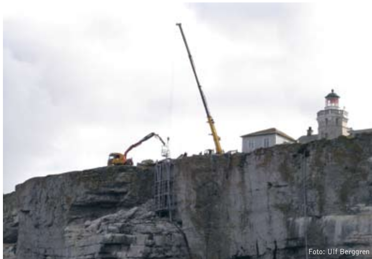
Stålkonstruktionen lyfts på plats på Stora Karlsö.
